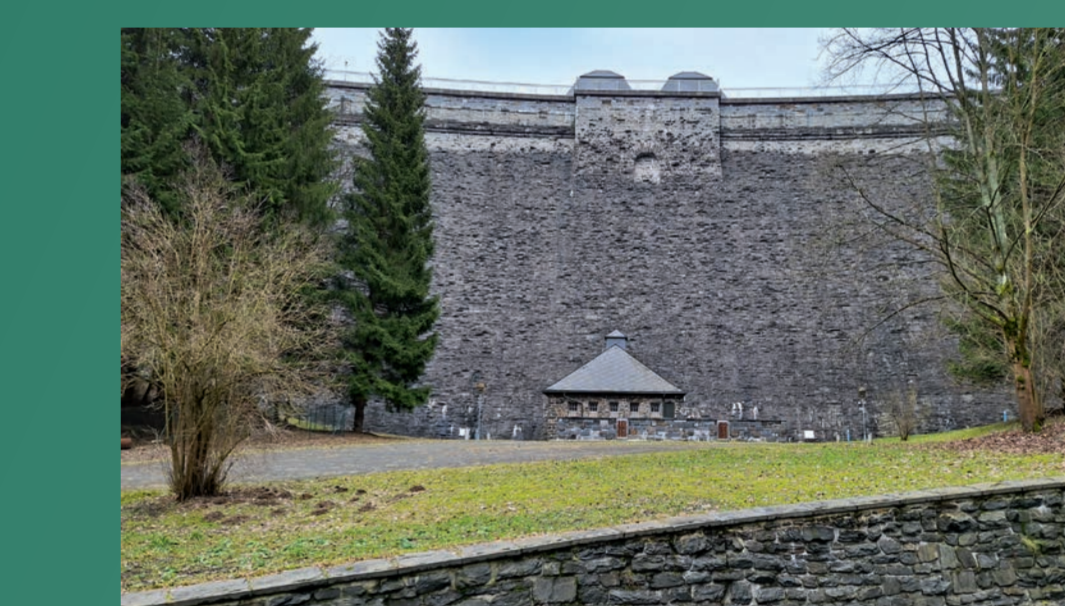
Schieberhaus am Fuß der Staumauer.
