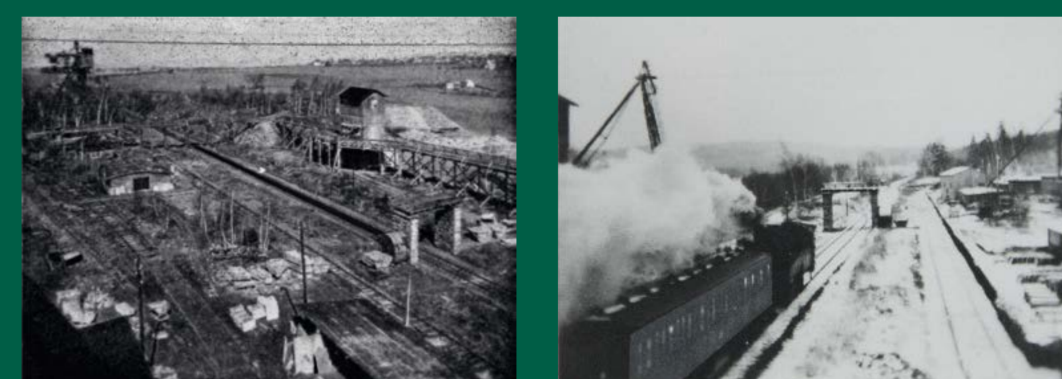
Verladebahnhof in Theuma mit Kabelkran, 1964.
